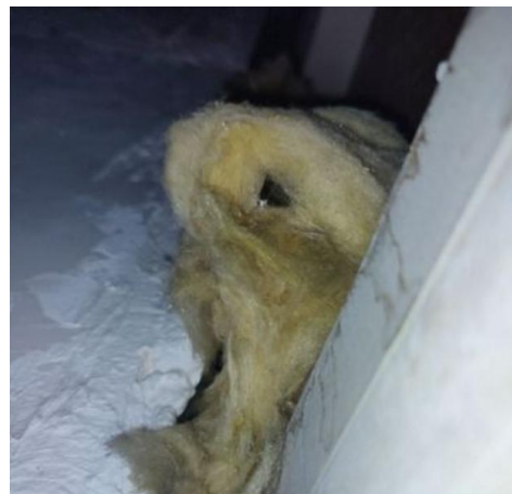
Exemple de raccordement des trappes de désenfumage constaté sur site
